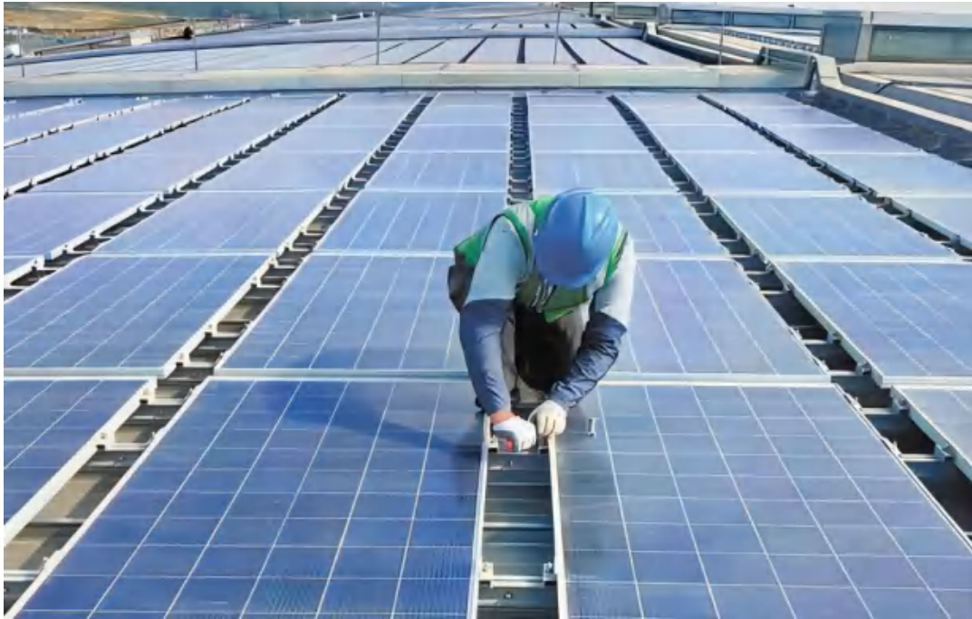
图 3-9 运维人员检查光伏组件和电气设备情况
