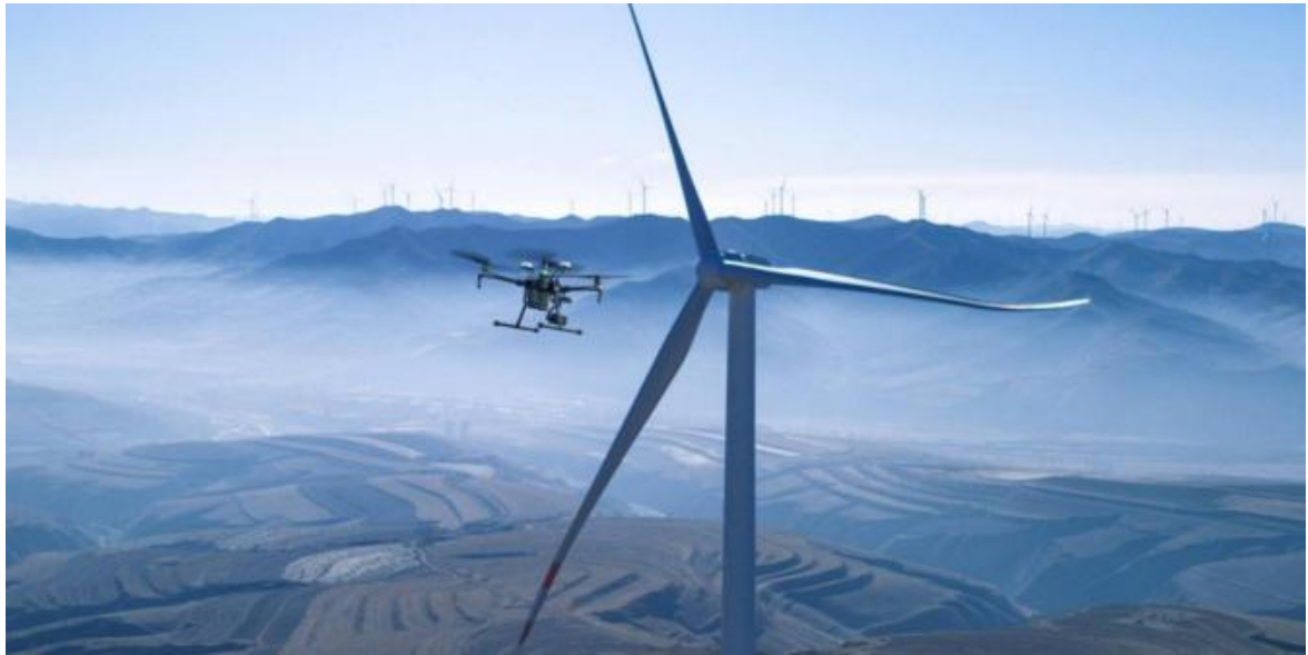
图 3-8 风电无人机巡检工作
